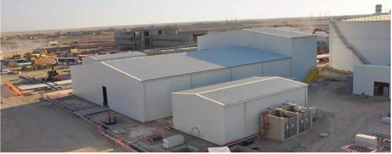
Al Kharirat Power Plant - Irak / Taşyünü Cephe Paneli
